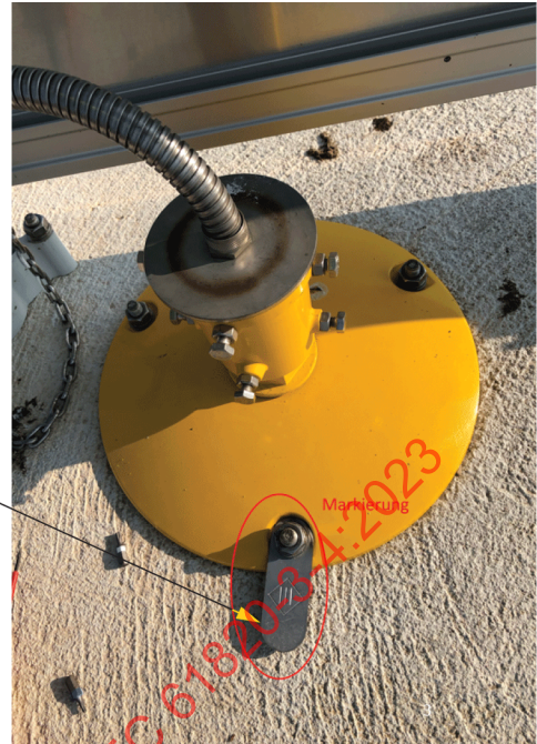
Figure B.3 – Exemple de marquage de terrain (feux hors-sol)
